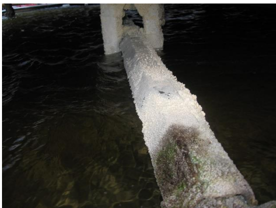
Evaporatív kondenzátor kiinduló állapot
